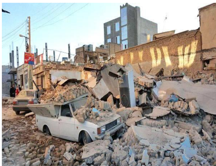
شکل ۹: زلزله بجنورد ۱ مهر ۱۴۰۳ (پایگاه خبری انتخاب)
